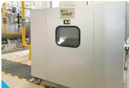
燃氣鍋爐燃燒器消音罩應用：在中心醫院能源站燃氣鍋爐燃燒器處安裝燃燒器消音罩，減低噪音8-10分貝。
