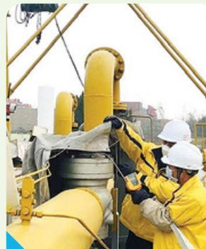
在門站次高壓管線檢漏作業
