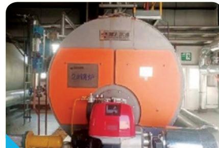
便攜式煙氣燃氣鍋爐低氮改造：對國藥能源站、北方嘉科能源站、熱力五站、京濱1號站8台燃氣鍋爐進行低氮改造，氮氧化物排放由80mg/m<sup>3</sup>降低至30mg/m<sup>3</sup>以下，減少氮氧化物排放量
